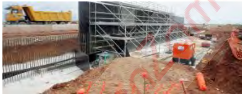
Obras del Ave en Montamarta, a 18 kilómetros de la capital zamorana. :: LUIS CALLEJA
