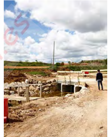
Puente construido para acceder a Valderrey desde el polígono de La Hiniesta. Foto Emilio Fraile
