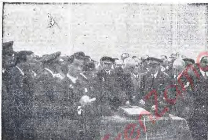
El momento en que S. E. el Presidente de la República hizo explotar los barrenos con que se iniciaban las obras del ferrocarril Zamora-Orense
